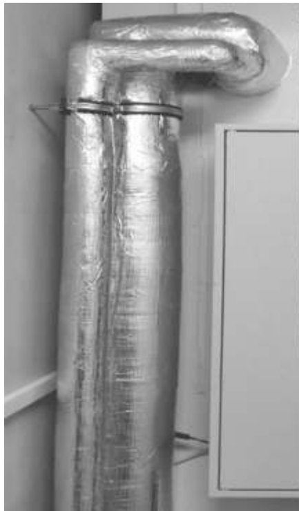
Fot. 12. Ruroci gwizolacji standardowej ródło: M. Borzymowicz
